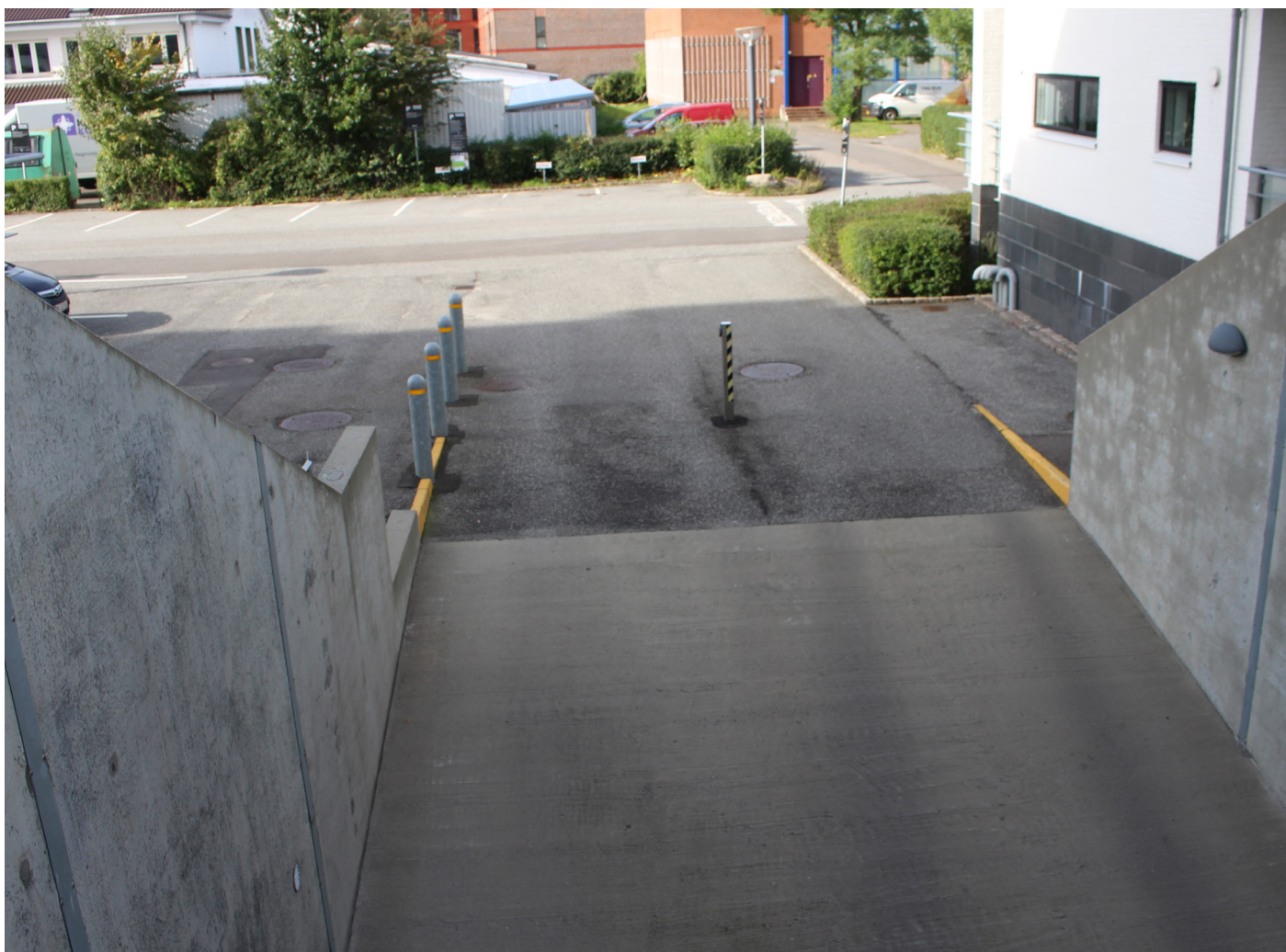
Nedkørsel til p-kælder. Byparken, Vejle.
