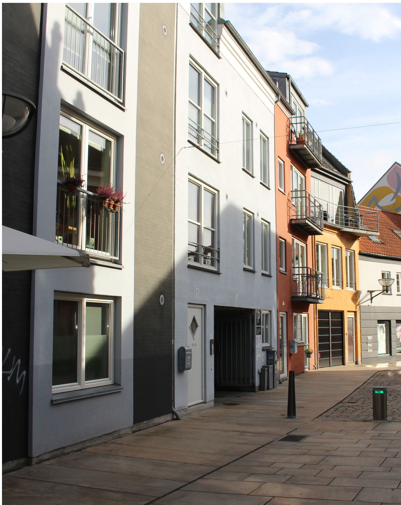
Byggeriet i forgrunden er opdelt vertikalt for at falde ind i gadebilledet. Grønnegade i Vejle.
